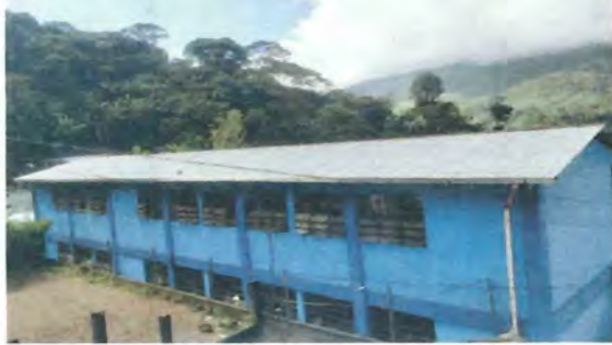
Foto 1: Sustrución de cubierta de lámina y mantenimiento de estructura de techo en el módulo de las aulas.
