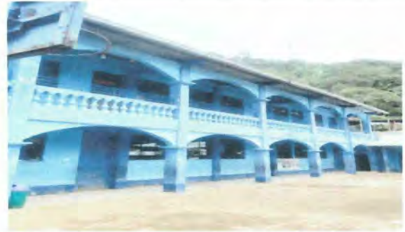
Foto 2: Sustrución de canal y bajadas de agua pluvial por encontrarse en mal estado en el Módulo 2.
