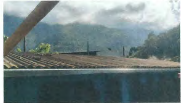
Foto 4: Sustrución de cubierta de lámina y mantenimiento de estructura de techo en el módulo de servicios sanitarios 1.
