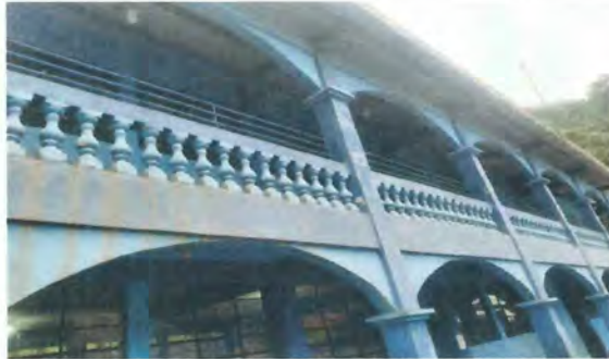
Foto 3: Mantenimiento de muros con aplicación de pintura en las paredes de los módulos a intervenir lado exterior de las aulas.
